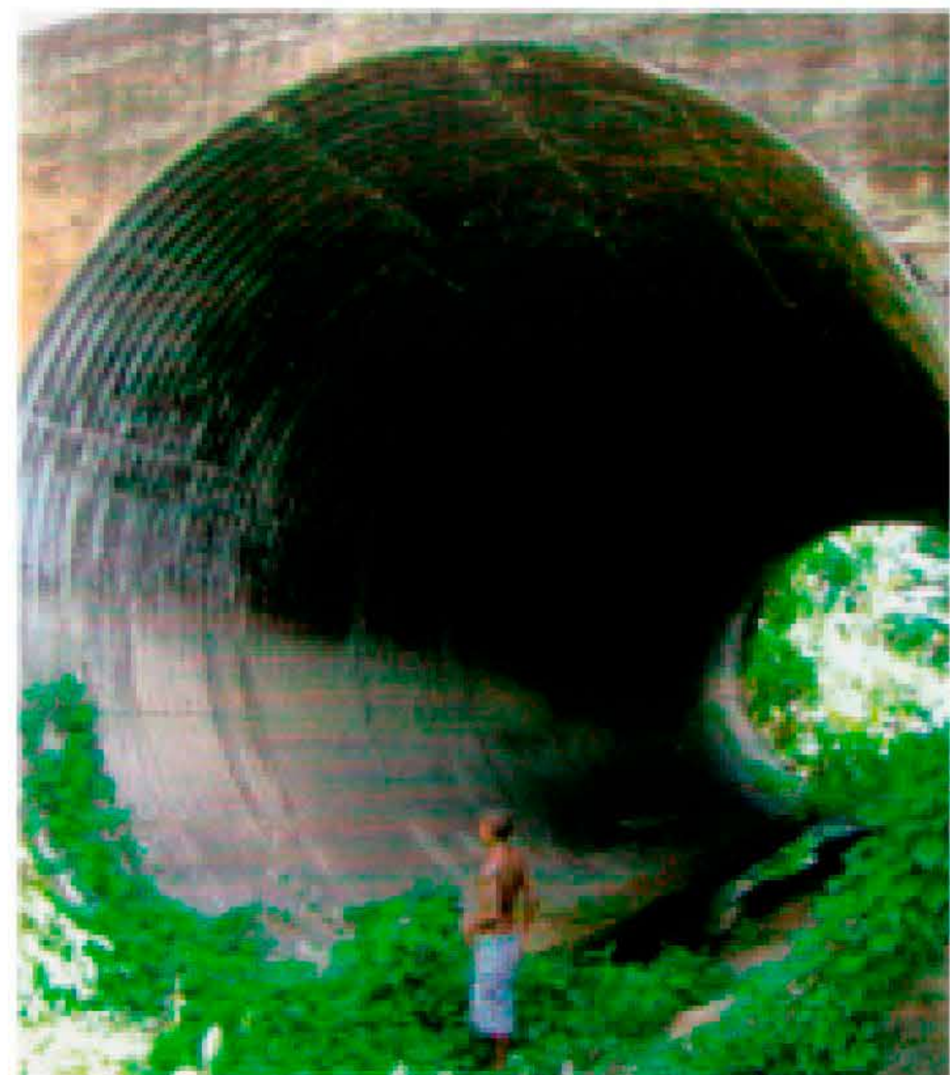
CORRUGACIÓN MP-152 (PG -152) (PASO GRANDE) 152 mm. de paso por 51 mm. de profundidad
